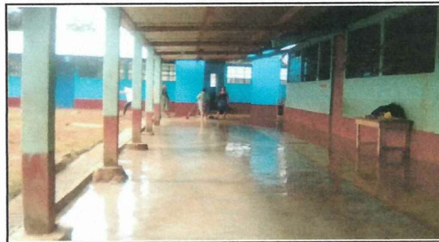
Foto 4: Se culminó con el entortado, frente tres aulas de primaria y donde funciona CEDODII, sin embargo es utilizada por los jóvenes del INBTS de Telesecundaria, Aldea Sesajal Las Pacayas, también, se colocó cunetas.
