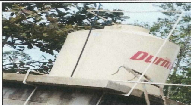
Foto 2: Se finalizó con la colocación del tinaco y con todos sus accesorios.
