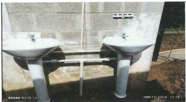
Foto 3: Se culminó con la colocación de los dos lavamanos con sus pedestales.
