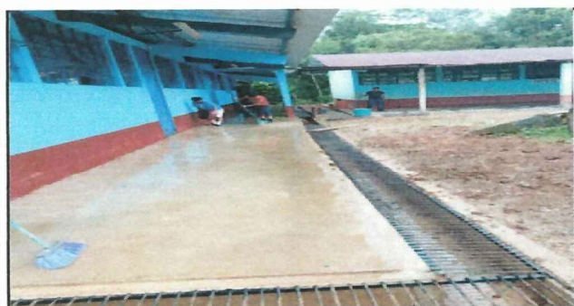
Foto 5: Se culminó con las cunetas de las aulas del nivel básico del Instituto Nacional de Educación Básica de Telesecundaria, Sesajal Las Pacayas.
